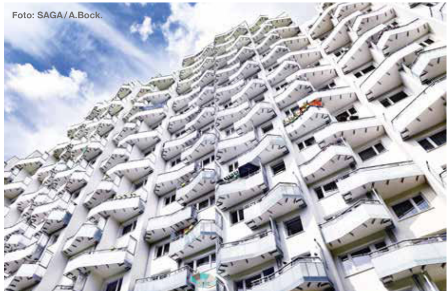
SAGA-Hochhaus Achtern Born 80-96 nach der Sanierung
