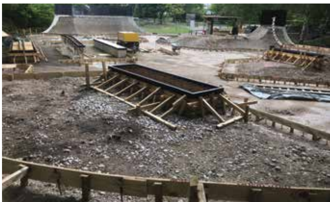
Der Skatepark ist im Bau, im Juli soll er fertig sein.
