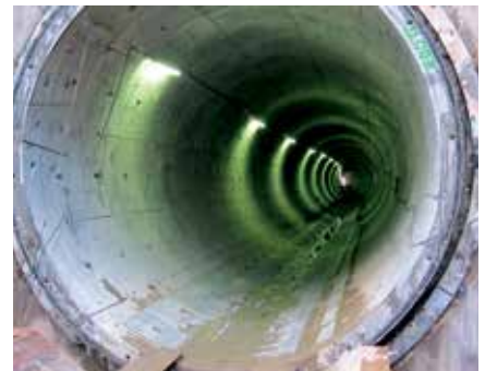
XFEL-Tunnel im Bau, 2011
