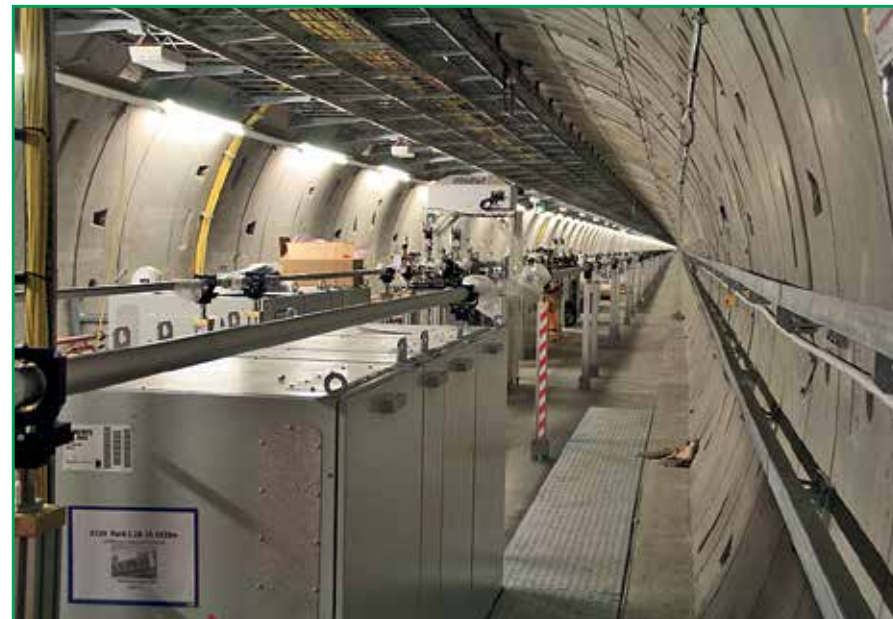
Röntgenlaser XFEL: Hochpräzise Technik im Tunnel
