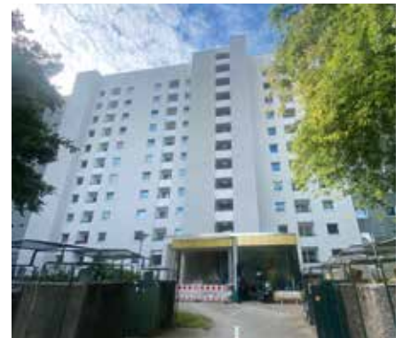
Diese Häuser an der Bornheide wurden saniert.
