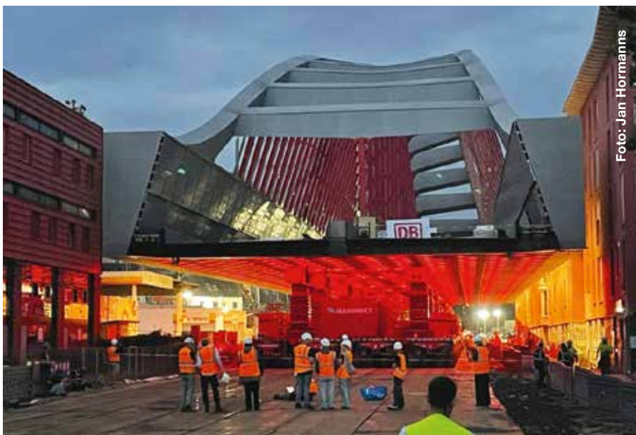
Am 30. Juli wurde die Sternbrücke durch die Max-Brauer-Allee transportiert.
